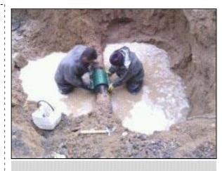
2月10日,氧化铝厂区内通往热电分 厂、高压溶出的生活水管道漏水,水电分厂 一车间立即组织抢修,检修员工在齐腰深的 冰水里清理管道表面、安装哈夫节、紧螺丝, 一系列检修程序有条不紊, 历时一个多小 时,顺利完成检修任务,恢复生产单位供水。 摄影报道 张芳玲
